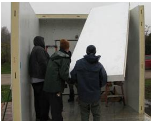
Figure 40. Assemblage du panneau de la boîte isolée
